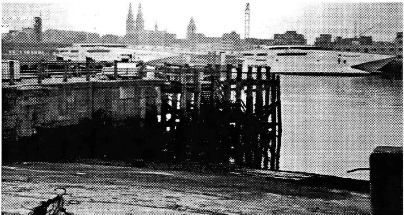
Deze helling is het overblijfsel van de eerste sluisen naar het visserijdok. Nu kan men er de overzet "De Link" nemen. Links in de muur ziet men waar de sluisdeuren zaten.
