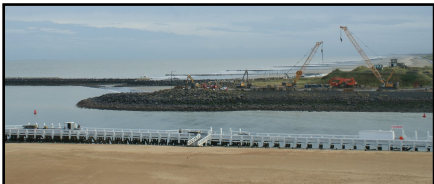
Toren gesloopt + verbredingswerken havengeul 31.10.2019
