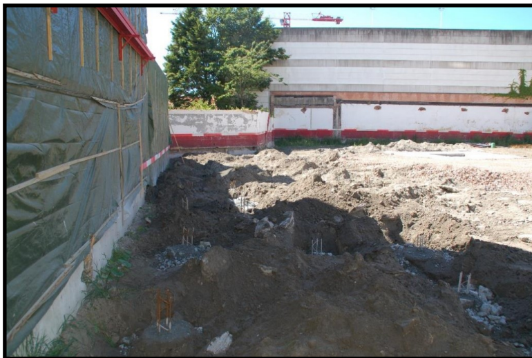
Afbeelding 2. Zicht op de resem gewapende paalfunderingen op plaats waar het schip uit de Bourgondische periode zich bevindt (foto Erwin Mahieu – 1 juli 2022)
