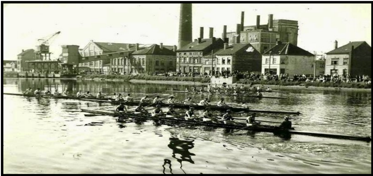
Roeiwedstrijd op de vaart. Op de achtergrond de elektriciteitscentrale van Sas-Slijkens
