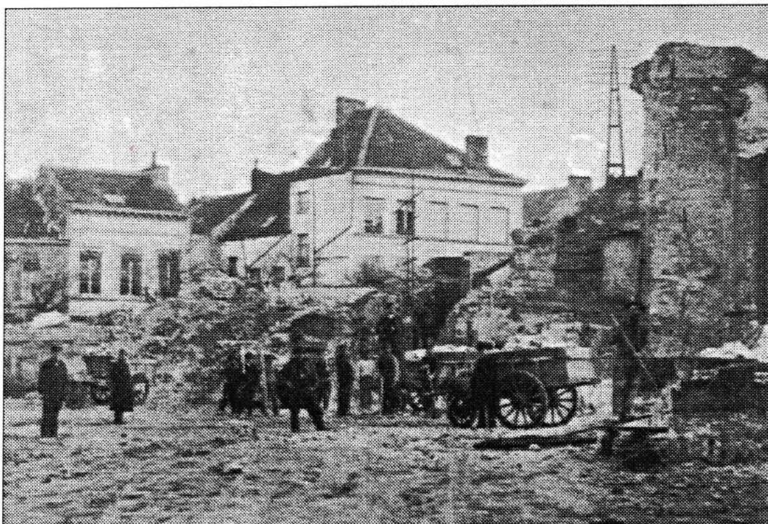
Afbraakwerken afgebrande kerk
