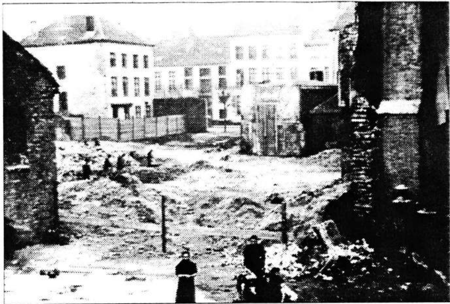
Tijdens de afbraak van de afgebrande kerk, links de opgetrokken noodkerk, rechts de 'Peperbusse', zicht richting Jozef II-street.
