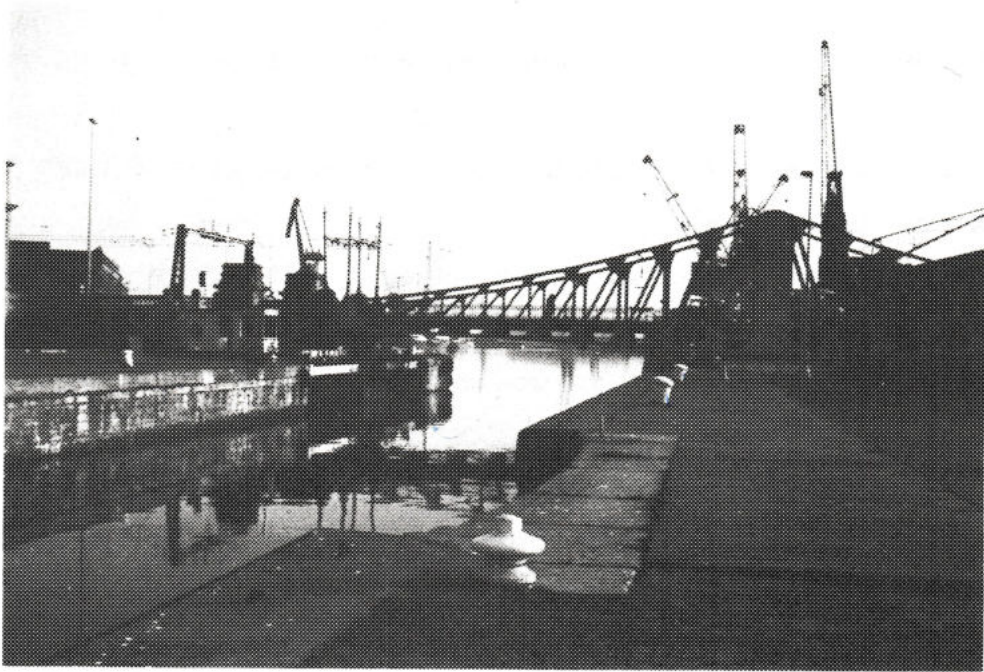
1. DEMEYSLUIZEN : MEN ZIET DE UITSPARING IN DE KAAIMUUR OP DE VOORGROND : DAAR ZATEN VROEGER OOK NOG DEUREN.
