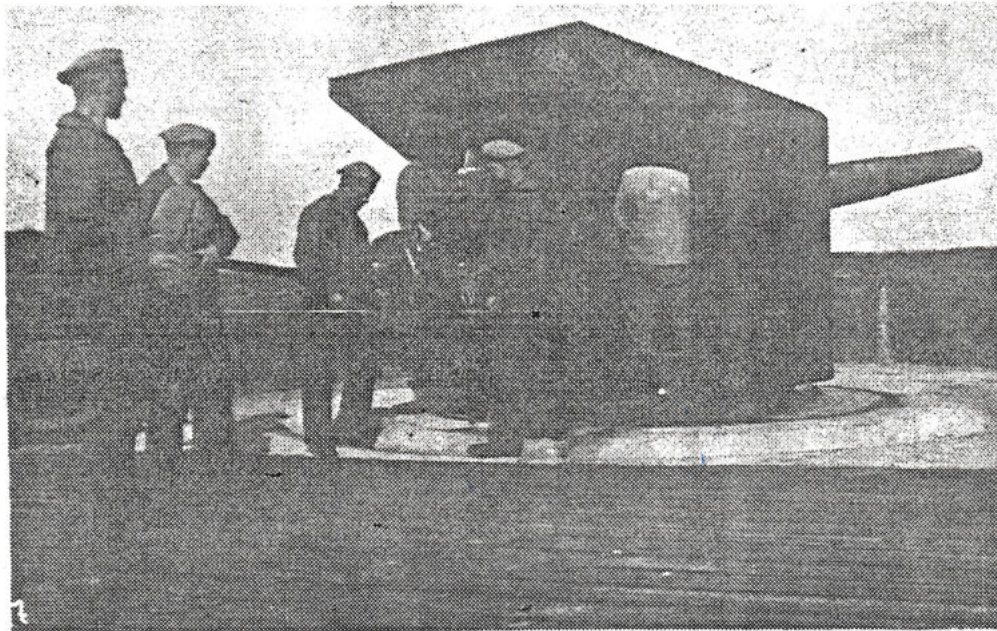
Mariakerke 1914-'18 : batterij Cecilie (naam van de echtgenote van de toenmalige Duitse kroonprins), gelegen onmiddellijk naast de batterij Beseler, richting Reversyde. De 4 geschutsstukken van 15 cm kaliber (zie illustratie) waren iets zwaarder dan die van de batterijen Beseler en Aachen (=domein Prins Karel)
